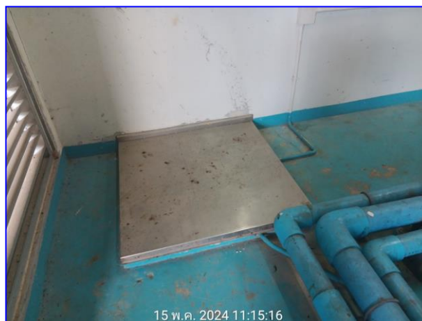
รูปที่ 2.8 ถังเก็บน้ำสำรอง (น้ำประปา)
